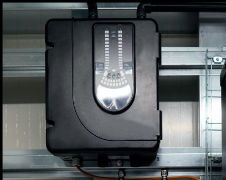
Sistema rilevamento Incendi/fumi, variaz. temperature, umidità e pressione
