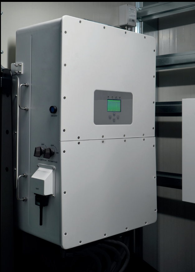
Inverter con logiche di controllo e di sicurezza ridondati
